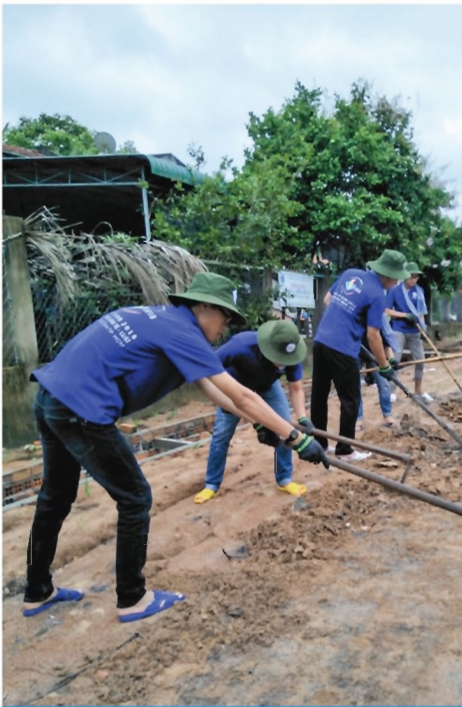
Chiến sĩ của đội hình Đức Chính góp sức làm thông thoáng con đường tại địa phương
